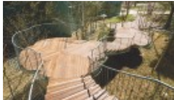
クローバーの葉をモチーフとしたウッド階段
