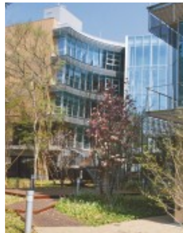
外部ウッド階段とシモクレンの花（左側に保存されたムクノキ）
